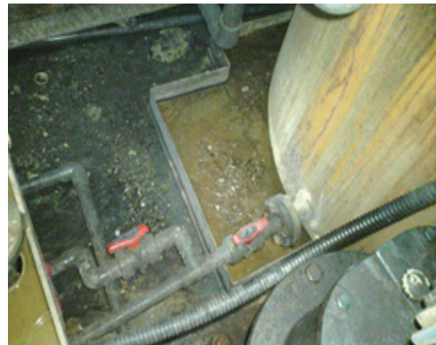
<그림 7> 사고 발생 염화제일철 보조탱크 상부 및 하부 누출 흔적
